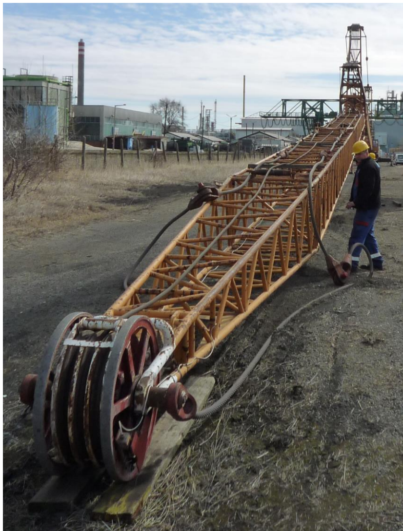
Kép az acélrács szerkezet talajon való szemrevételezése, csapkötéseinek vizsgálata 2.
