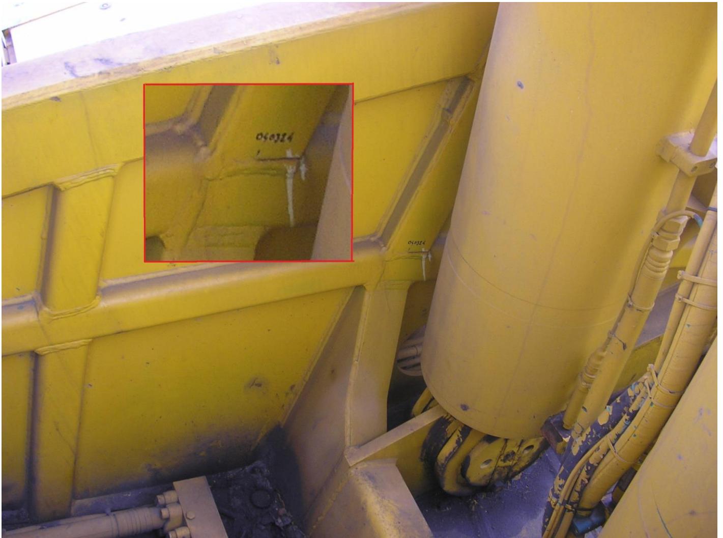
Szerkezeti repedés járműdaru acéllemez keretszerkezetén (forgó felsővázon) a repedés terjedési határ és a vizsgálati dátum feljelölésével
